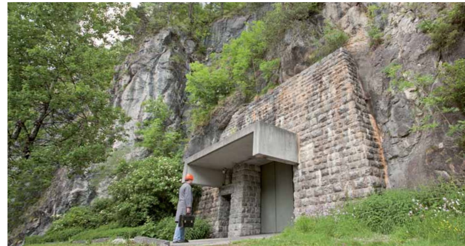
Eingang zur „Südkaverne“: In diesem Felsen wird das Wasser der SWM Brunnen gesammelt. Durch eine 60 Kilometer lange Leitung wird es von hier nach München geleitet.
