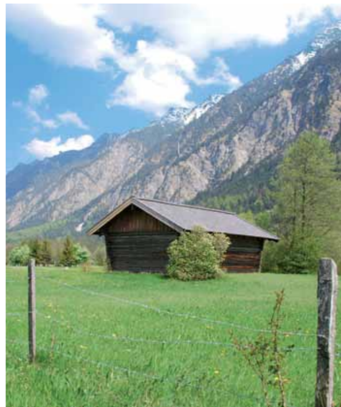
Eines von fünf Brunnenhäusern zwischen Farchant und Oberau.
