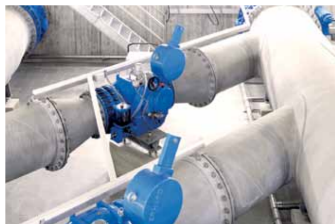
Zuleitung in den Hochbehälter Deisenhofen.
